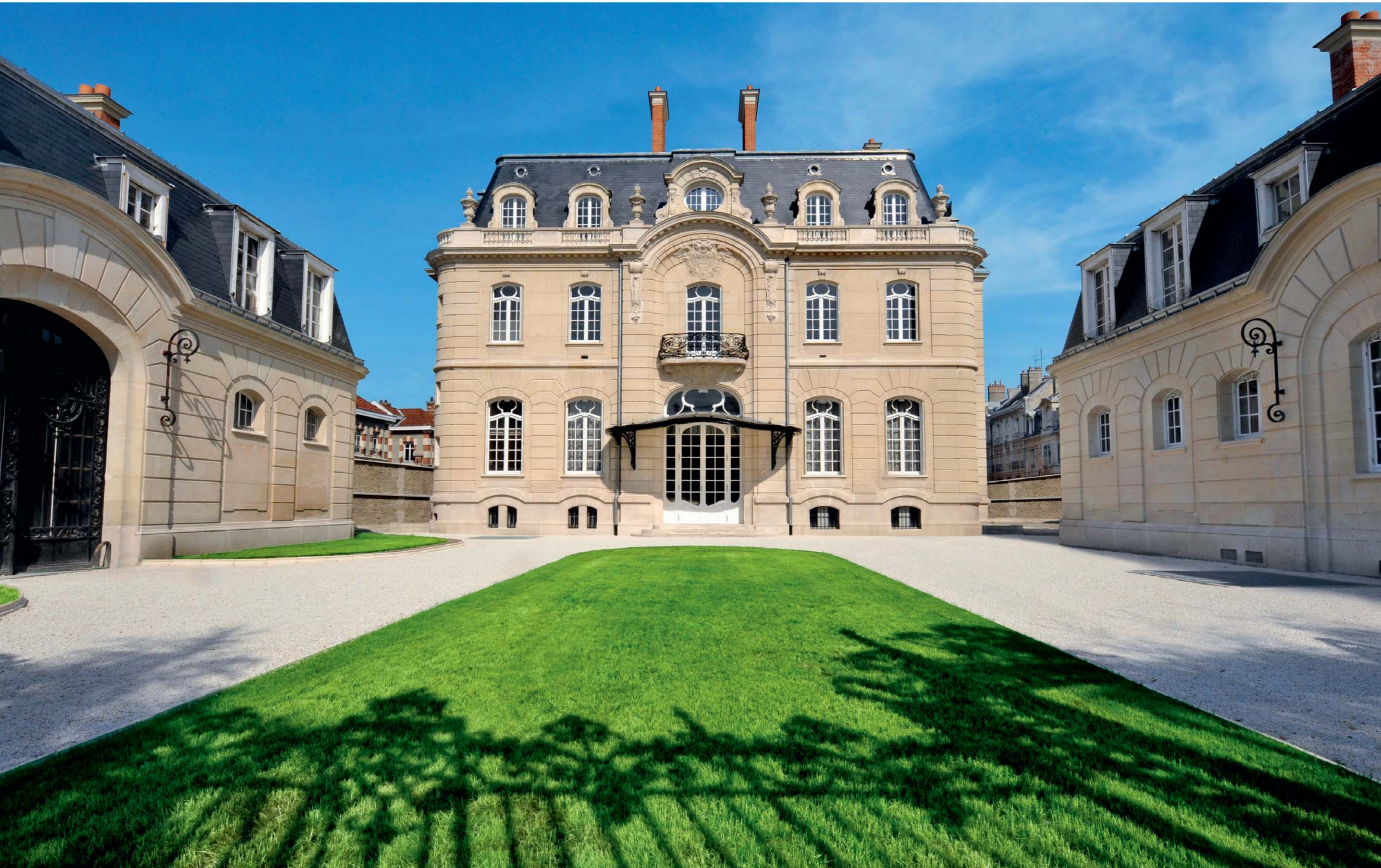
Entouré de deux pavillons, l'hôtel particulier figure parmi les plus belles bâtisses de Reims. L'ensemble, en pierre de taille sur les quatre façades, affirme l'élégance et le raffinement de l'hôtel.
